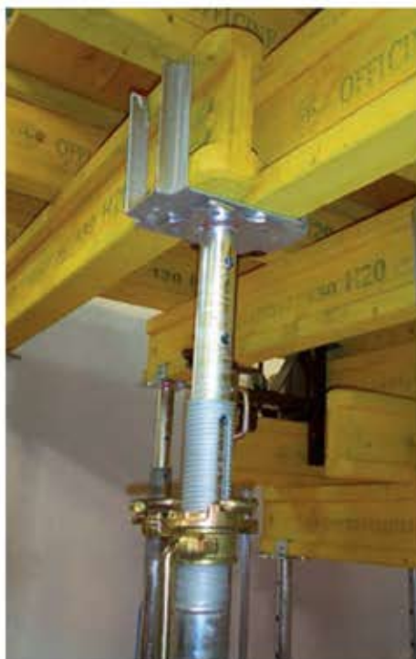
Forca a 4 punte zincata 4-ways fork, hot dip galvanized
